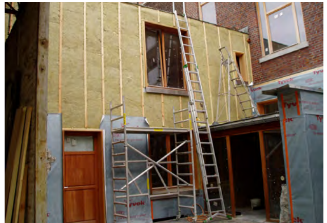
Isolation par l'extérieur et étanchéité de l'annexe.
