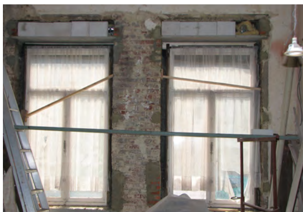
Remplissage des caissons à volets par de l'isolant.
