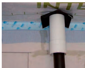
Raccord de percement en cours autour d'une décharge, Source CSTC
