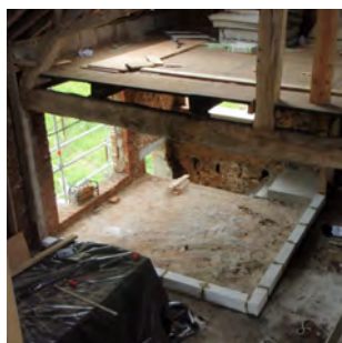
Terrasse au 1 er étage, nouveau plancher au 2 e .
