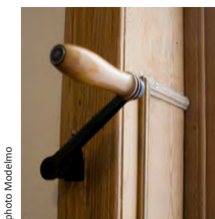
Volet roulant avec manœuvre à manivelle
