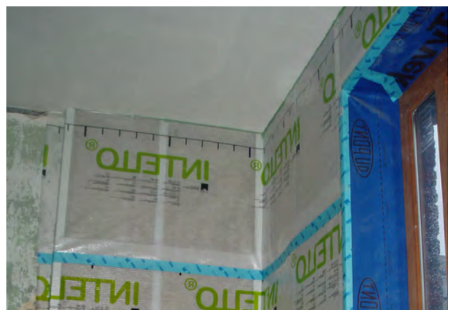
Freine-vapeur et étanchéité à l'air.
