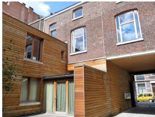
Façade arrière et annexe après rénovation.
