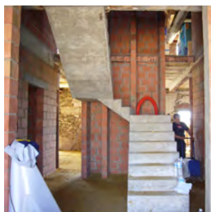
Noyau central vu du rez-de-chaussée.
