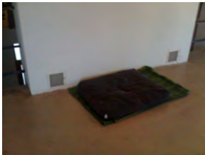
Bouches d'arrivée d'air chauffé par le poêle à l'arrière de la trémie centrale.
