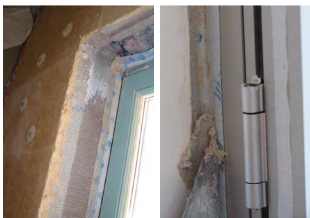
Bandes d'étanchéité autour des châssis. Raccord à l'isolant intérieur ou au plafonnage.
