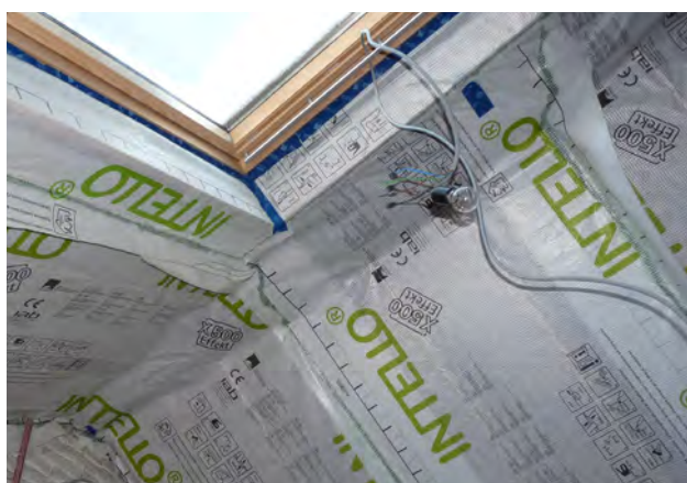
Etanchéité à l'air des baies et de la toiture.
