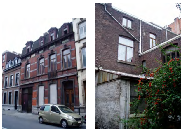
Façade avant et annexe avant rénovation.
