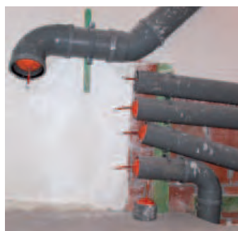
Zone non plafonnée derrière des tuyauteries, Source CSTC
