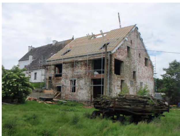
Rénovation de la toiture.
