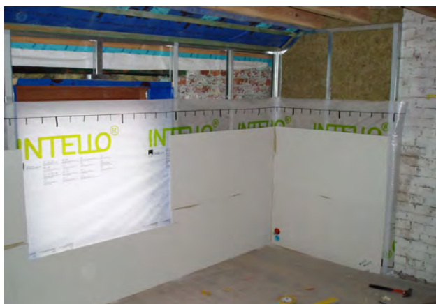
Isolation par l'intérieur du bâtiment principal - façade arrière.
