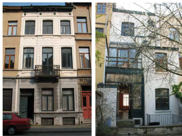
Façade avant et arrière avant rénovation.
