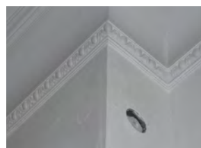
Arrivée d'air hygiénique (bouche de pulsion à placer).
