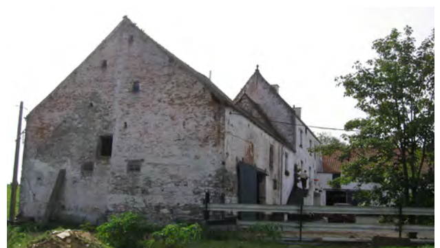
Bâtiment A avant rénovation.
