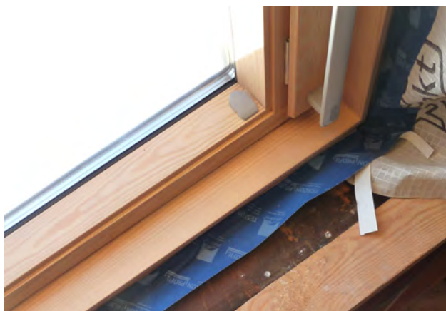
Bandes d'étanchéité autour des châssis. Raccord à l'isolant intérieur ou au plafonnage.
