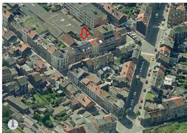
Le bâtiment pilote de l'asbl Eco'Hom s'inscrit dans le projet de rénovation urbaine du quartier Saint-Léonard à Liège.
