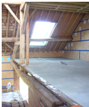
Cellulose insufflée derrière les panneaux OSB.
