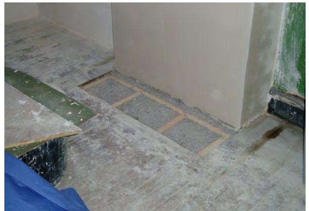
Isolation des planchers intermédiaires en cellulose.
